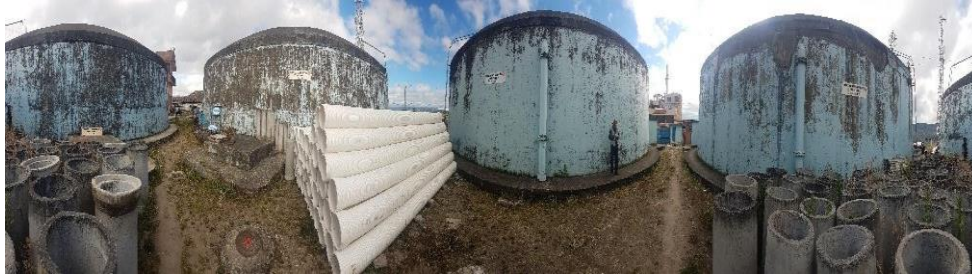
Figura 7-4 Panorámica de Tanques de Reserva
