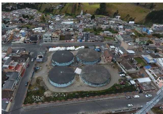
Figura 7-3 Vista Aérea – Tanques de Reserva
